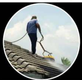
Limpeza a presión del tejado o las tejas
